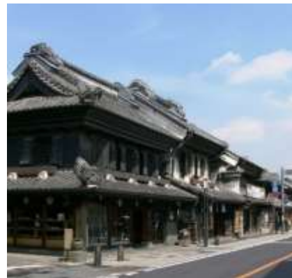
（整備後） 【埼玉県川越市】
